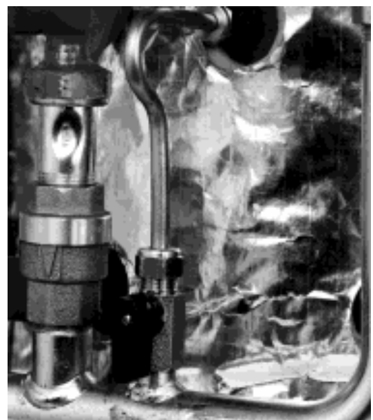
Фото А: Кран заполнения
