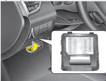
Внутренняя панель плавких предохранителей
