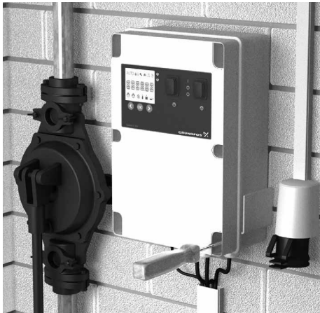
Рис. 8 Монтаж шкафа управления LC 221
