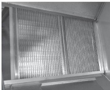
Пластинчатый рекуператор (рис. 14)
